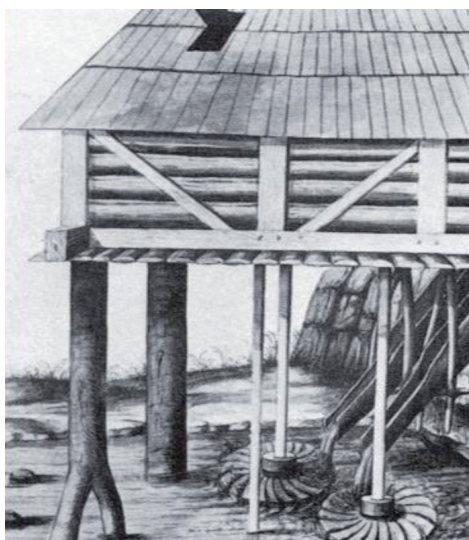
3. kép Kétkerekű kanalas patakmalom Bulgáriában INALCIK, 2001, 299. (43. illusztráció)
